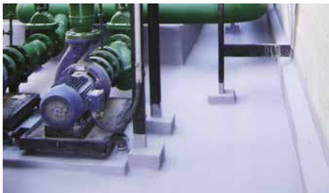
Sistemas em MMA moldados no local permitem aplicação horizontal e vertical e acabamentos perfeitos nas interfaces com ralos, canaletas e demais interferências.
